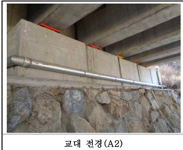
【사진 17.3.31】 교대 전경
