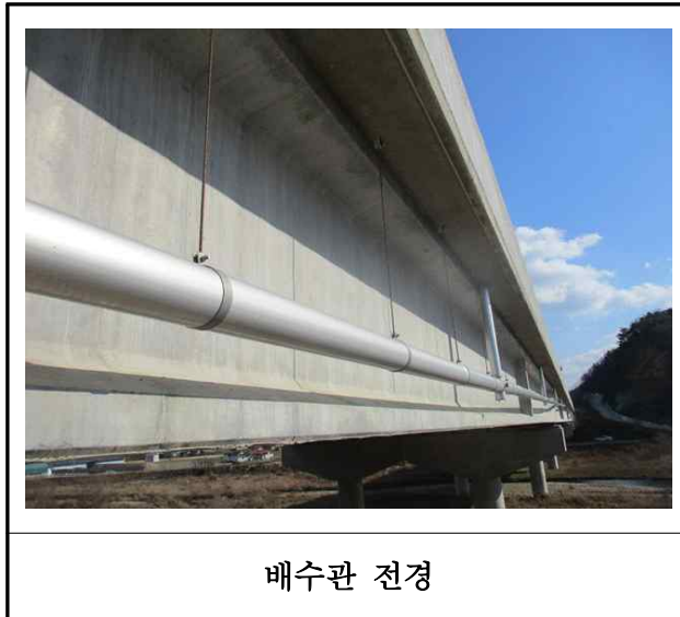
【사진 17.3.44】 배수시설 전경
