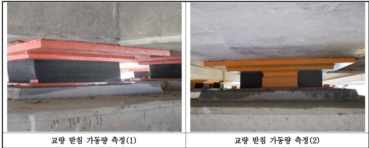
【사진 17.3.38】 교량받침 이동량 측정
