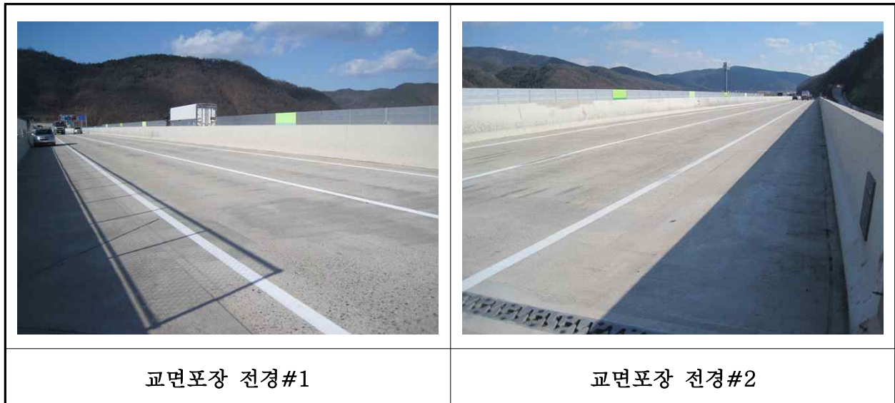
【사진 17.3.42】 교면포장 전경
