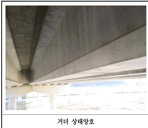
【사진 17.3.5】 거더 손상현황
