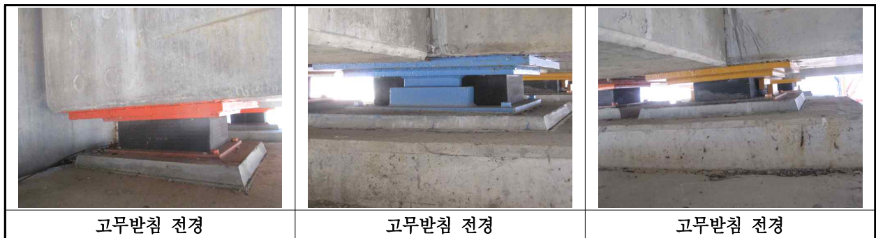
【사진 17.3.12】 교량반침 전경
