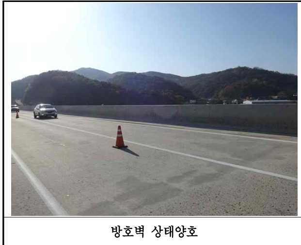
【사진 17.3.24】 방호벽 손상현황
