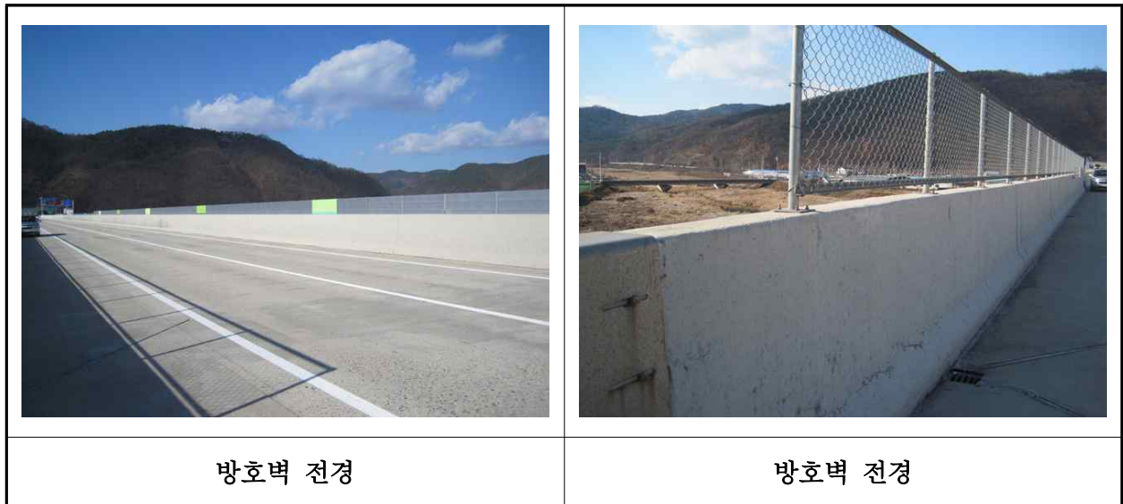
【사진 17.3.46】 방호벽 및 중앙분리대 전경
