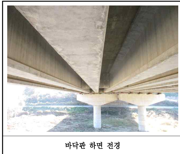
【사진 17.3.2】바닥판하면 전경
