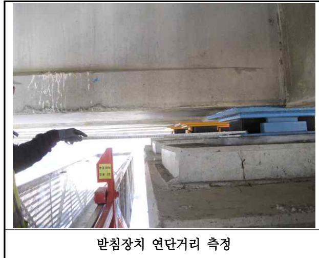
【사진 17.3.37】 교량받침장치 연단거리측정
