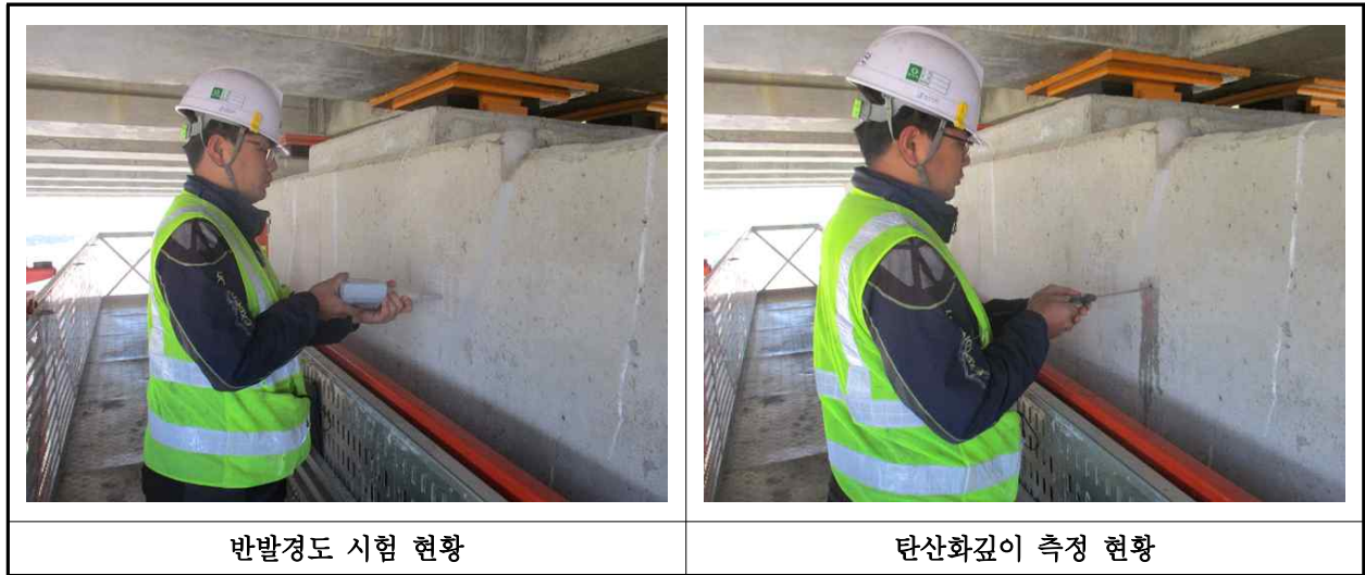
【사진 17.4.1】 콘크리트 내구성조사 현황
