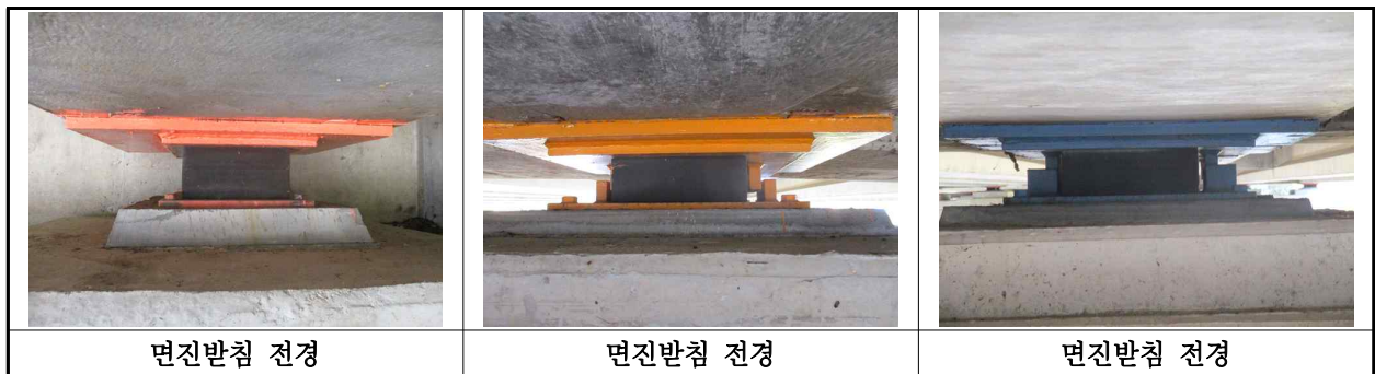
【사진 17.3.35】 교량반침 전경
