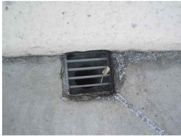
배수시설 상태 양호
